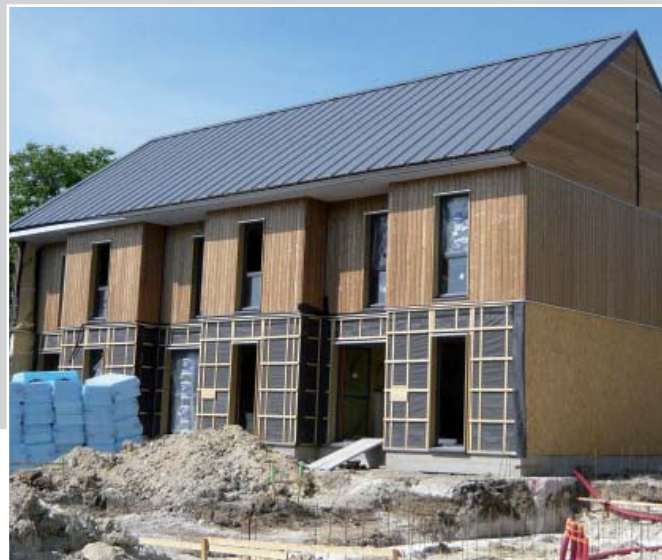
Champigny-sur-Marne : Résidence Le Pharsale (logements à structure bois)
