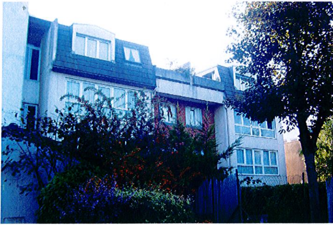
LA SOURCE (44 logements) - 527 et 591 av Maurice Thorez
