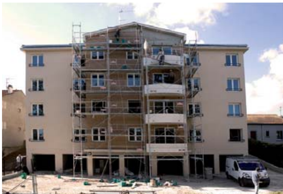
Le Four à Chaux - Ce programme de 16 logements locatifs sociaux vient d'être mis en location. Il est situé au 225/233 rue de Bernau à Champigny sur Marne.
