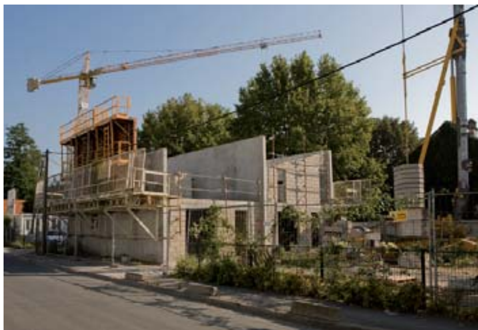
Résidence Chemin de la Ferme - Une première tranche de travaux composée de 16 pavillons et 19 logements collectifs locatifs sociaux sont en cours de réalisation et devrait être livrée en Juin 2008. Cette opération est située angle rue Yves Farges et rue Pierre Marie Derrien à Champigny sur Marne.
