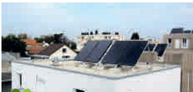
Résidence «Les Poneys» [Champigny-sur-Marne]. La moitié des besoins d'eau chaude sanitaire est assurée grâce à des panneaux solaires installés sur les toitures et couplés aux chaudières
